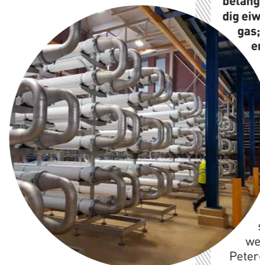
Met ultrafiltratie vervangt Avebe hitte door druk en bespaart daarmee niet alleen veel energie, maar ook veel water.
